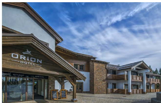
Hotel Orion, Krušné hory, vnitřní systém vzduch/voda
