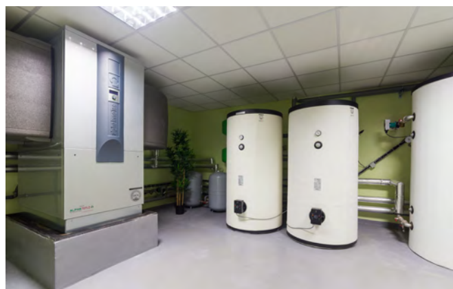
Rekonstrukce bytového domu, vnitřní systém vzduch/voda
